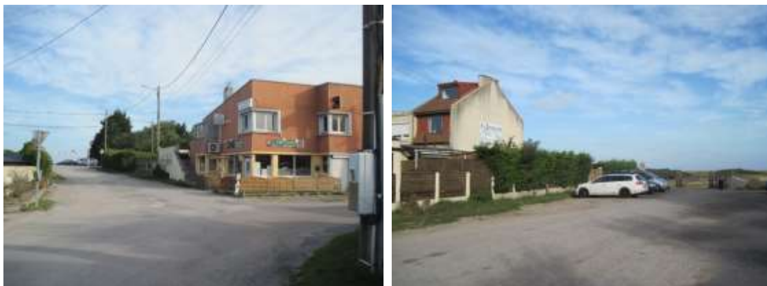
Vues générales du lieu-dit « l'Abri Côtier » et du parking desservant la réserve naturelle du Platier d'Oye qui sont en zone rouge .
